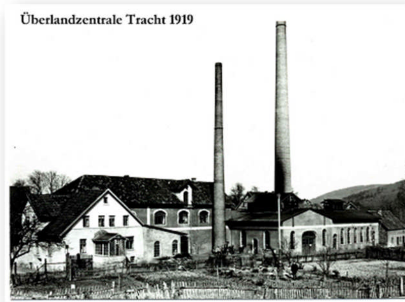
Abb. 2 Kleinwasserkraftanlage Tracht in Kalletal-Hohenhausen. (Foto Sammlung Autor)
